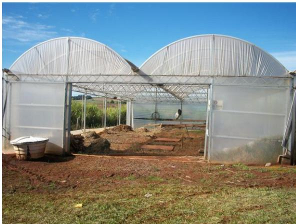
**Figura 1:** Estrutura que recobre o conjunto de 12 lisímetros.
