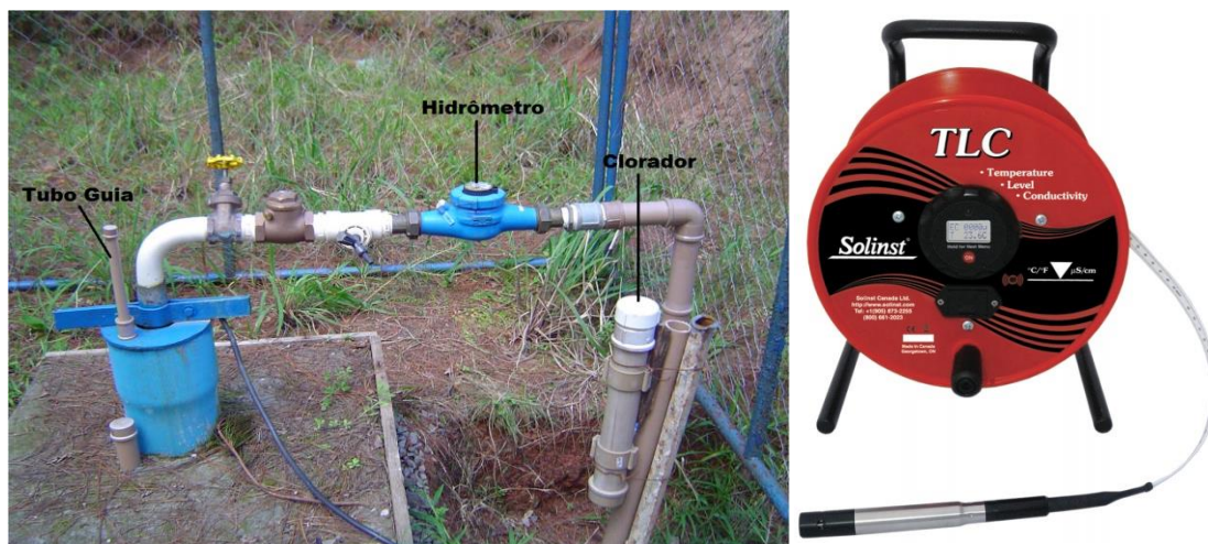
Figura 2 – Poço tubular da UFSM e freatímetro Sonoro TLC Solinst
